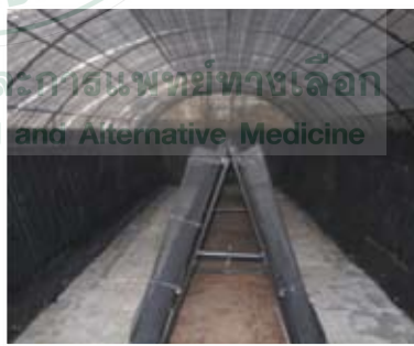
แผงวางก้อนเชื้อเห็ดเป็นชั้นตะแกรงเหล็ก แบบเอเฟรม
