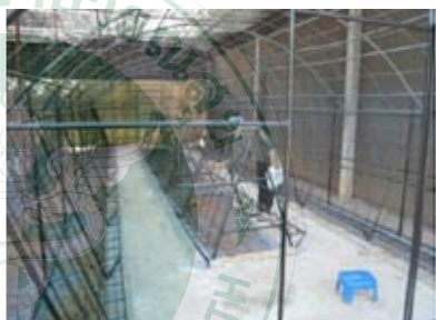
การทาสีกันสนิมโครงสร้างโรงเรือน
